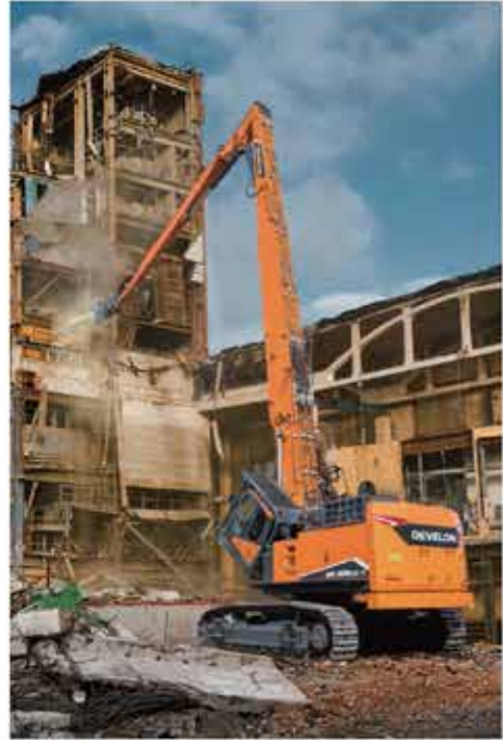
철거 가능 높이 36m : Only 데몰리션 Front 장착 가능 옵션 30톤급 칩클램프, 크라샤
