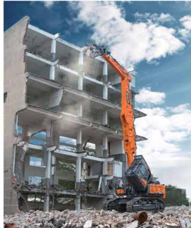
철거 가능 높이 19m : 디깅 Front 스트레이트 방식 장착 장착 가능 옵션 38톤 급 칩클램프, 크리사
