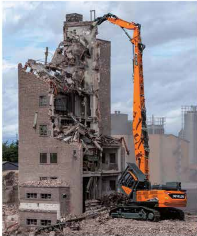
철거 가능 높이 28m : 데몰리션 Front + 연장 보조봉 장착 26m : 연장 보조봉 철거 시 26m 장착 가능 옵션 30톤 급 칩클램프, 크리사
