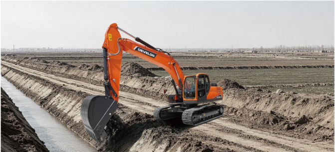
水利渠道开挖
