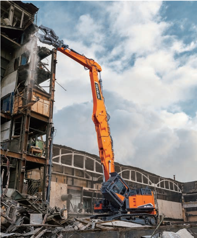
철거 가능 높이 22m : 디깅 Front + 연장 보조붐 장착 장착 가능 옵션 55톤급 콕클램프, 크라샤
