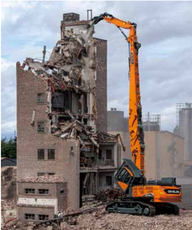
철거 가능 높이 28m : 데몰리션 Front + 연장 보조붐 장착 26m : 연장 보조붐 탈거 시 26m 장착 가능 옵션 30톤 급 킥클램프, 크라샤
